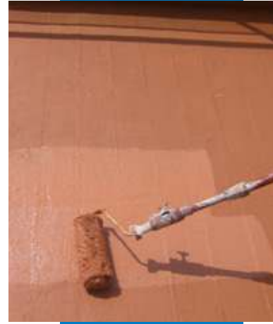
Thi công Aquaflex Roof bằng rulo có sợi dài
