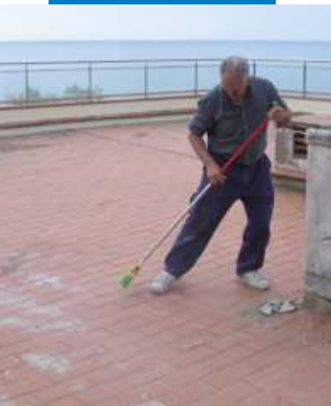
Làm sạch bề mặt trước khi thi công Aquaflex Roof
