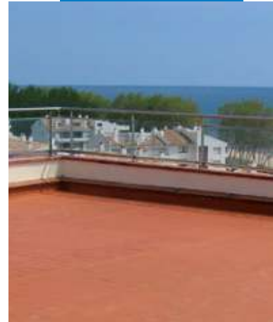
Chống thấm tẩm ốp lát bề mặt bằng Aquaflex Roof
