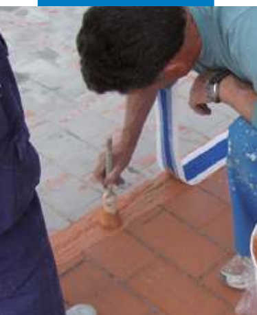
Chống thấm các mối nối tiếp giáp bằng cách dán Mapeband vào vị trí cần chống thấm bằng Aquaflex Roof
