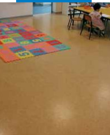
Sàn vải linoleum được trải trên sàn vừa tự san phẳng Ultraplan Eco - Trường mầm non Mirabello - Cantù (Como) - Ý
